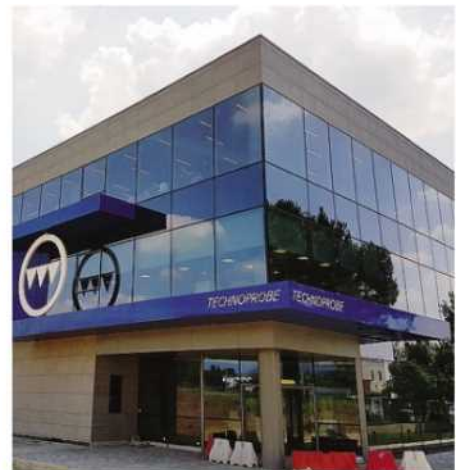
La nuova fabbrica della Technoprobe di Cernusco Lombardone
